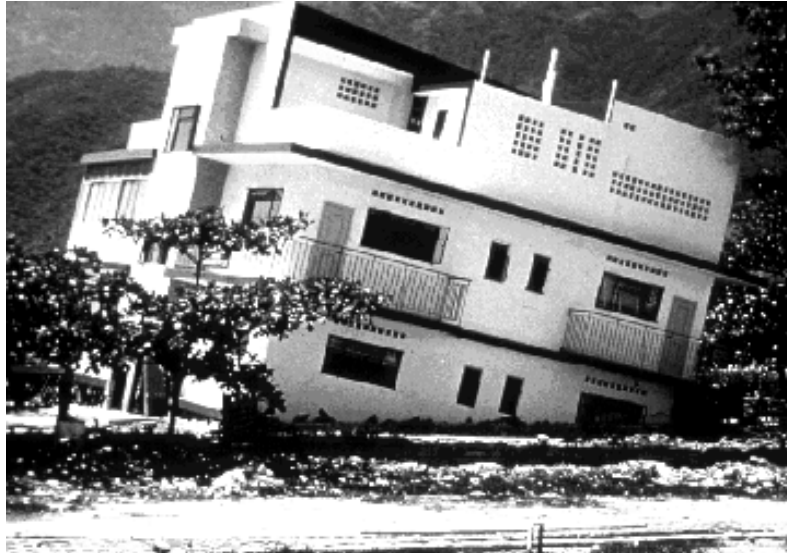
Figura 8. Ejemplo de licuación de suelo.
