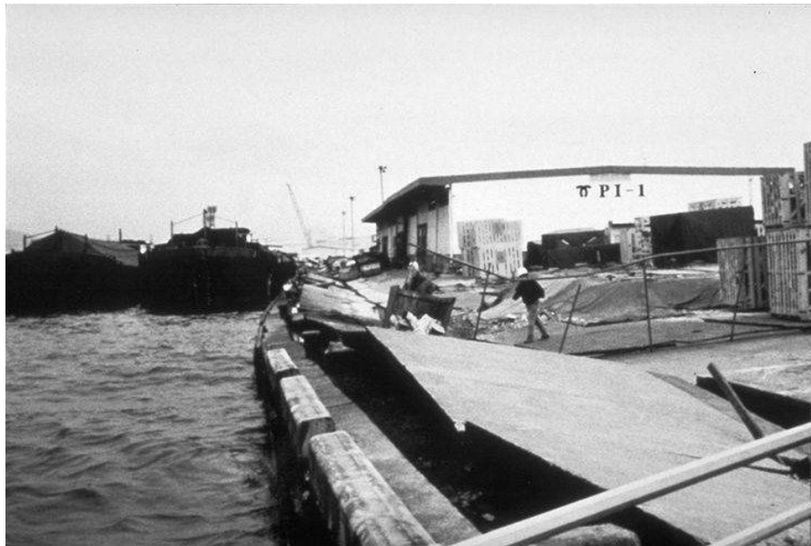
Figura 15. Fallas en muros de sostenimiento.
