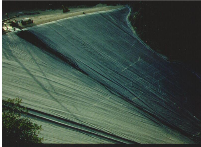
Figura 7.20: Geomembrana colocada sobre el talud de una presa de material suelto, antes de colocar el rip rap.
