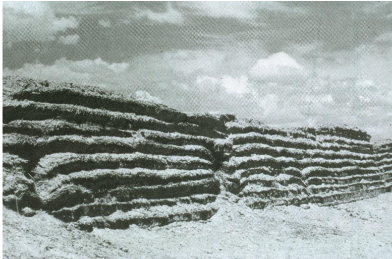
Figura 7.1. Parte de la muralla china construida hace 200 años con “geosintéticos”.
