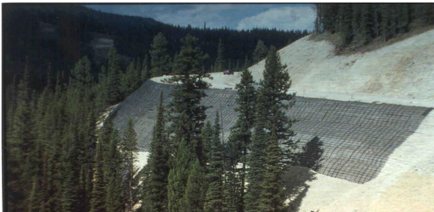
Figura 7.15: Geomantas colocadas sobre un talud para prevenir efectos de erosión.
