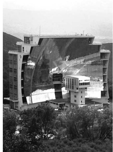
El espejo parabólico del horno solar en Odeillo (Francia) tiene varios pisos de altura. La energía electromagnética solar es reflejada hacia el foco del espejo donde la densidad energética es tal que la temperatura que genera, hasta  $4000^\circ\text{C}$ , puede fundir metales con alto punto de fusión.
