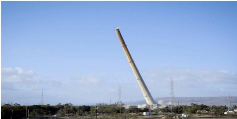
Demolición de chimenea de 200 m de antigua central eléctrica de carbón, en Australia
