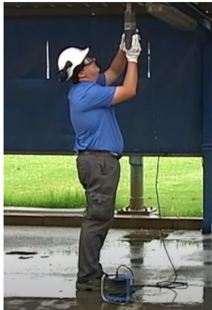
figura 7.3: Operario trabajando en la lluvia
