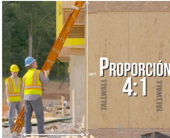
La forma correcta de utilización para este tipo de escaleras es colocándola respetando la relación 4:1 para que mantenga su estabilidad y adecuado funcionamiento.
