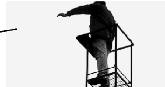
Plataforma de trabajo equipada con barandas y zocalo
