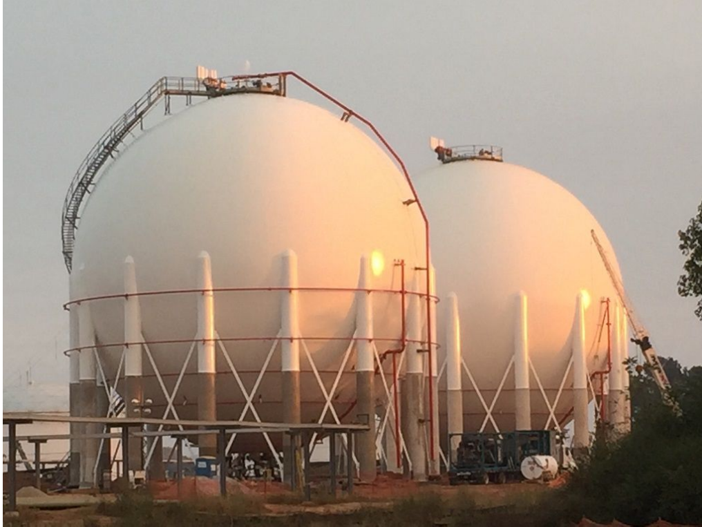
Recipientes esféricos de almacenamiento de grandes volúmenes
