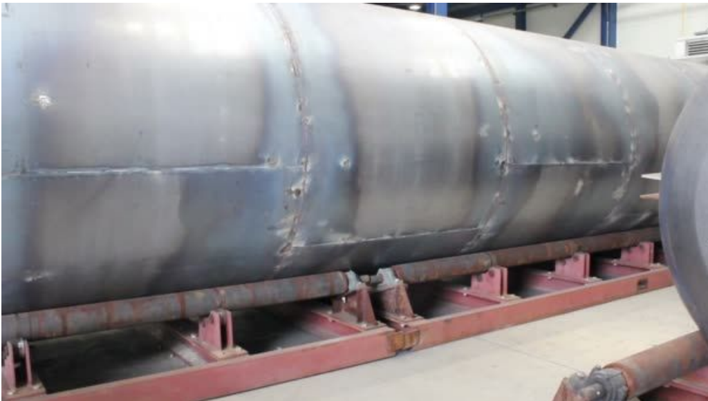
Se puede apreciar un tanque de almacenamiento de gasolina y las soldaduras realizadas en el mismo
