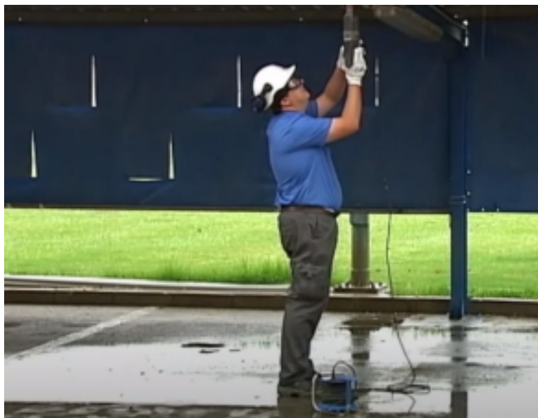
figura 7.3: Operario trabajando en la lluvia
