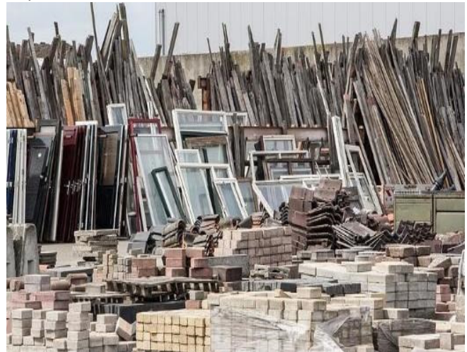
Fig 2: Desmantelado. Elementos recuperados
