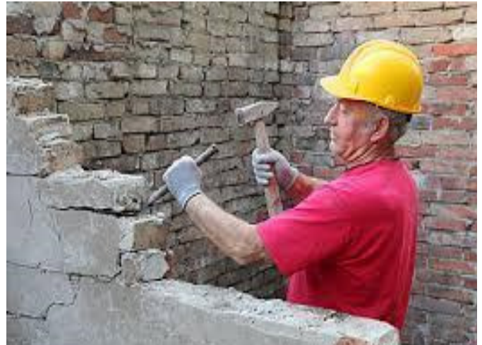
Fig 6: Demolición con martillo y cortafierro
