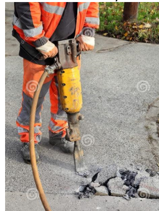
Fig 8: Demolición Martillo Neumático
