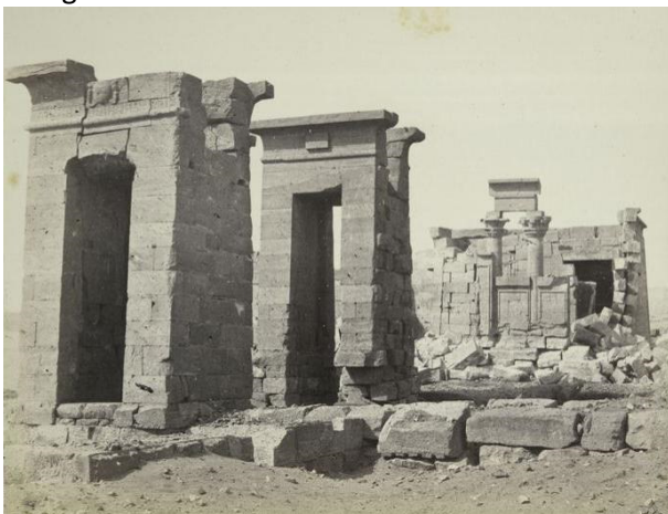
Fig 3: Demolición Total: Despiece
