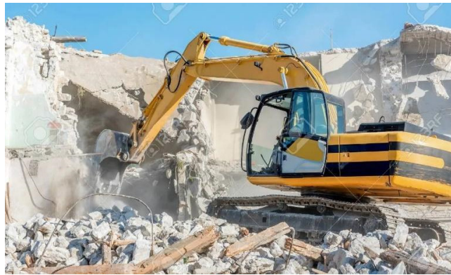
Fig 10: Demolición por empuje o arrastre
