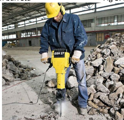
Fig 9: Demolición Martillo Eléctrico
