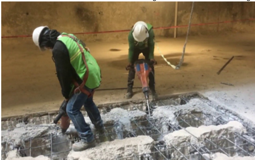
Fig 20: Demolición de Losa Nervurada
