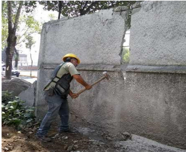
Fig 5: Demolición con maza
