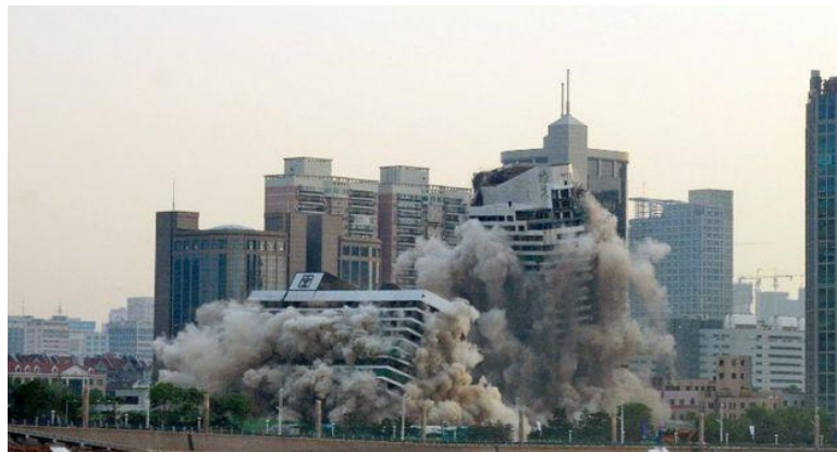
Fig 15: Demolición con Explosivos
