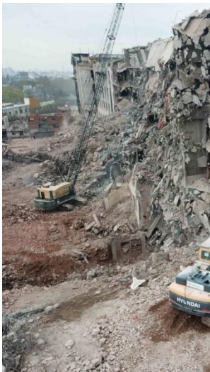
Fig 12: Demolición con bola del edificio “El Elefante Blanco” en Bs. As argentina realizada por la empresa Venegoni Hnos. S.A (venegonihnos.com.ar, https://mercadovial.tv/2018/10/08/elefante-blanco-mira-los-equipos-hyundai-responsalbes-de-demolerlo/ )
