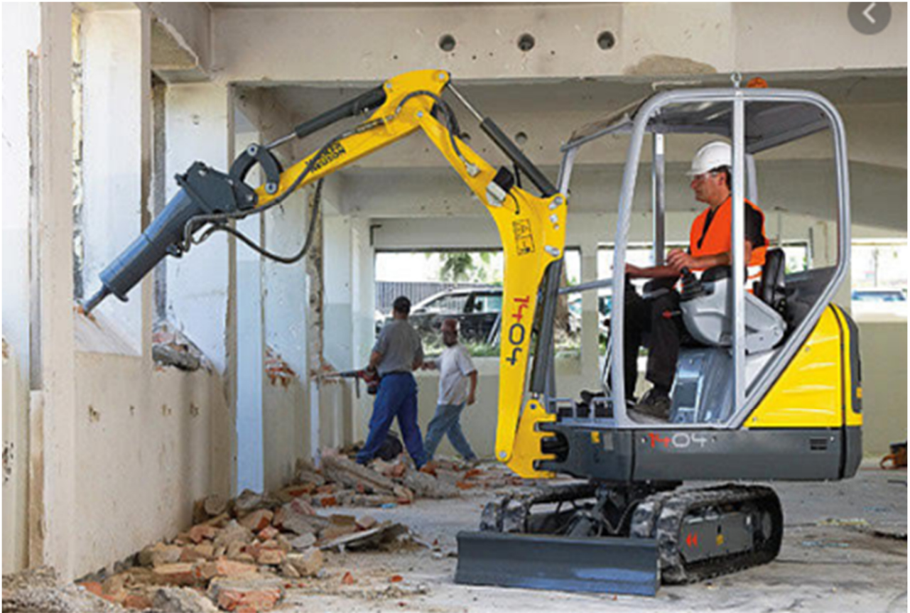
Fig 13: Demolición Martillo Hidráulico Compacto
