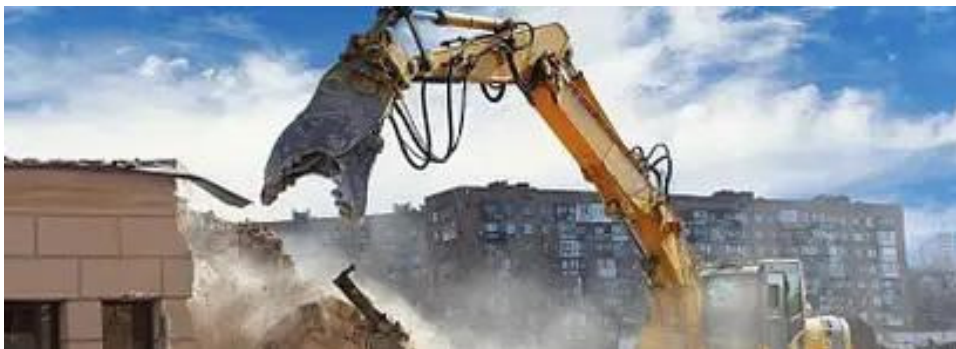
Fig 14: Demolición con Pinzas Demoledoras
