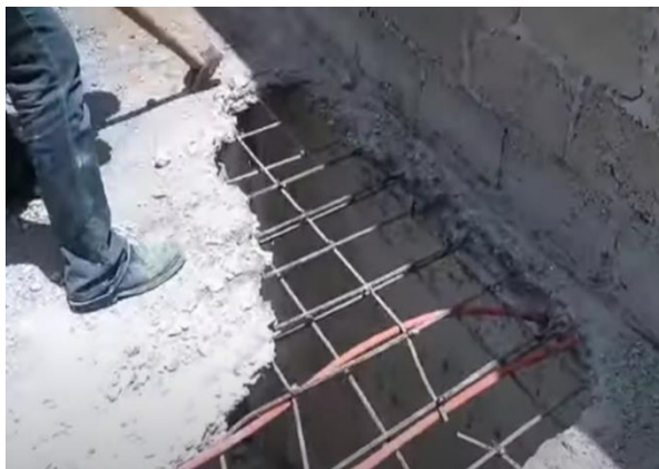
Fig 18: Demolición de losa maciza
