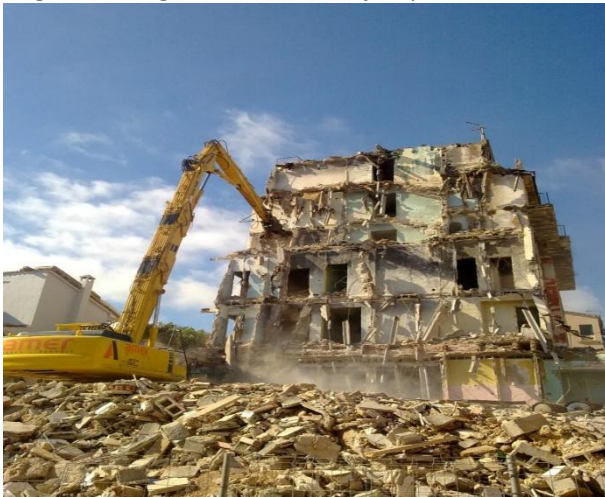
Fig 1: Demolición Total con destrucción total
