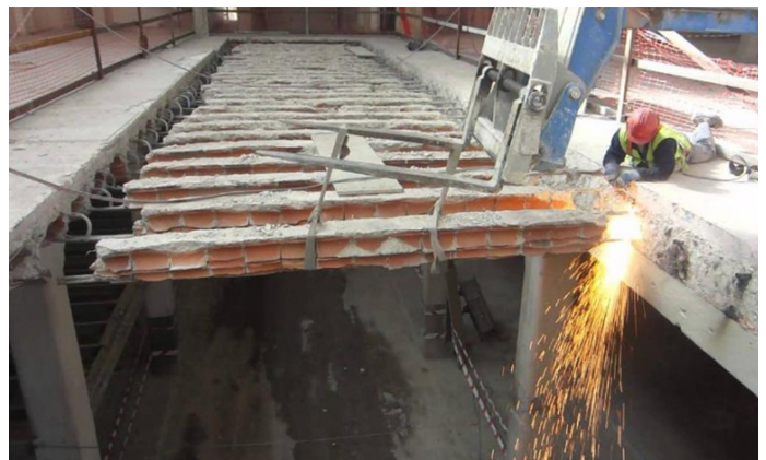
Fig 19: Demolición de Losa de Viguetas
