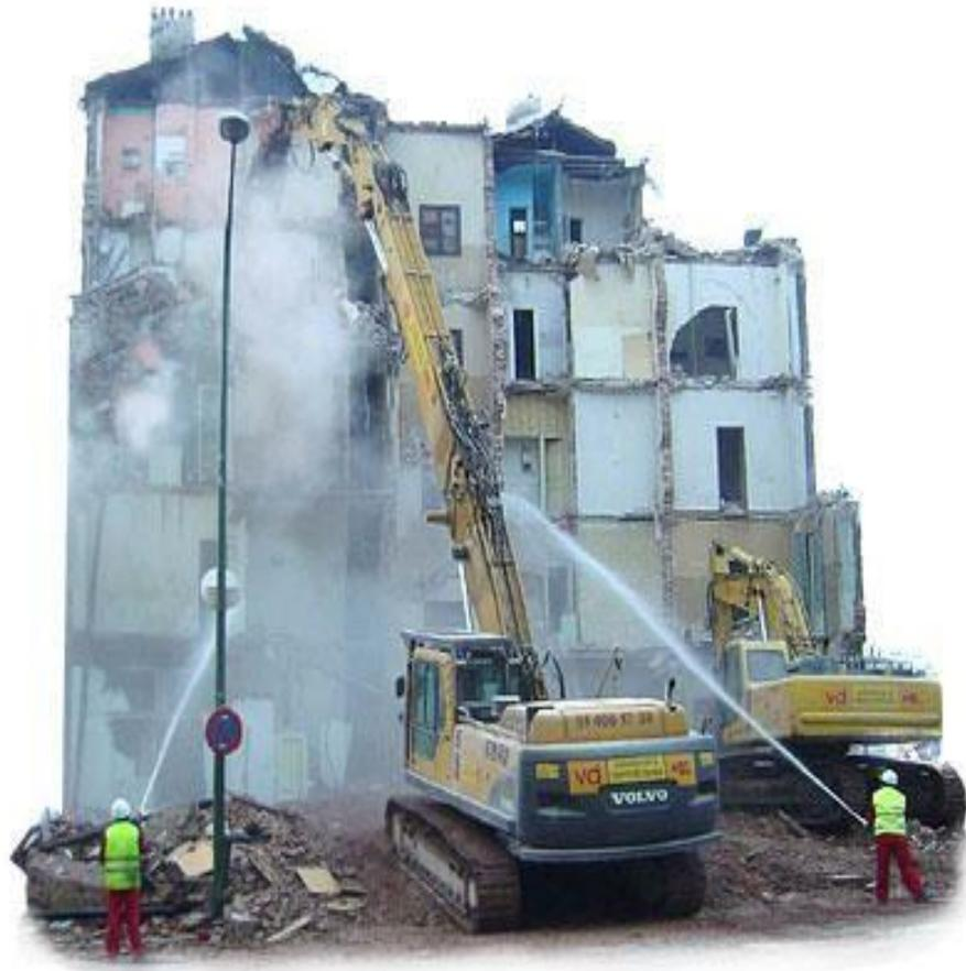
*Riego para control del polvo en la demolición*
