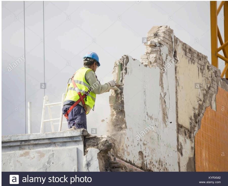
*Obrero demoliendo un muro en altura*
