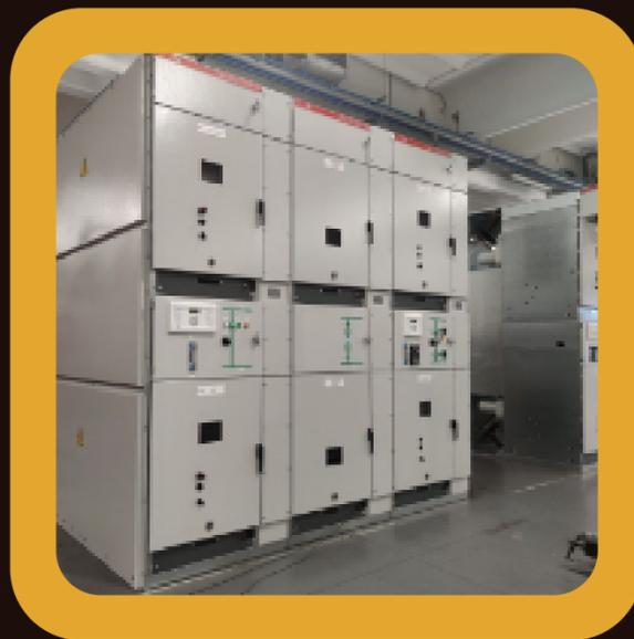
Protegen y evitan lesiones del operario. Poseen una envolvente capaz de soportar la presión y el calor generado por el arco, y poseen un conducto de escape que aleja la presión y gases fuera de la zona de trabajo.
