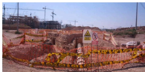
Balizamiento de servicios afectados (electricidad, gas,abastecimiento de agua).
