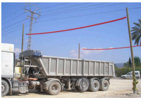
Pórticos para la delimitación de altura y zona de seguridad en presencia de línea eléctrica.
