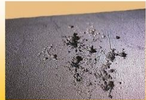
CORROSIÓN POR PICADURA
