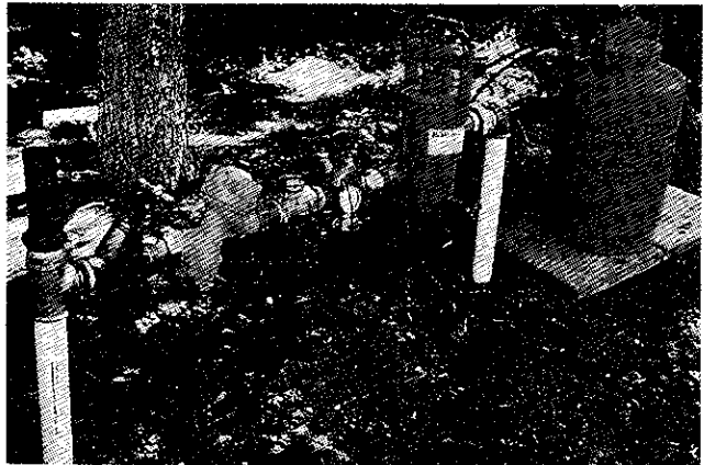
Foto 21. Cabezal de riego por goteo.
