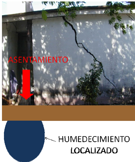
Figura 4.11. Agrietamiento de muro de una vivienda por humedecimiento localizado
