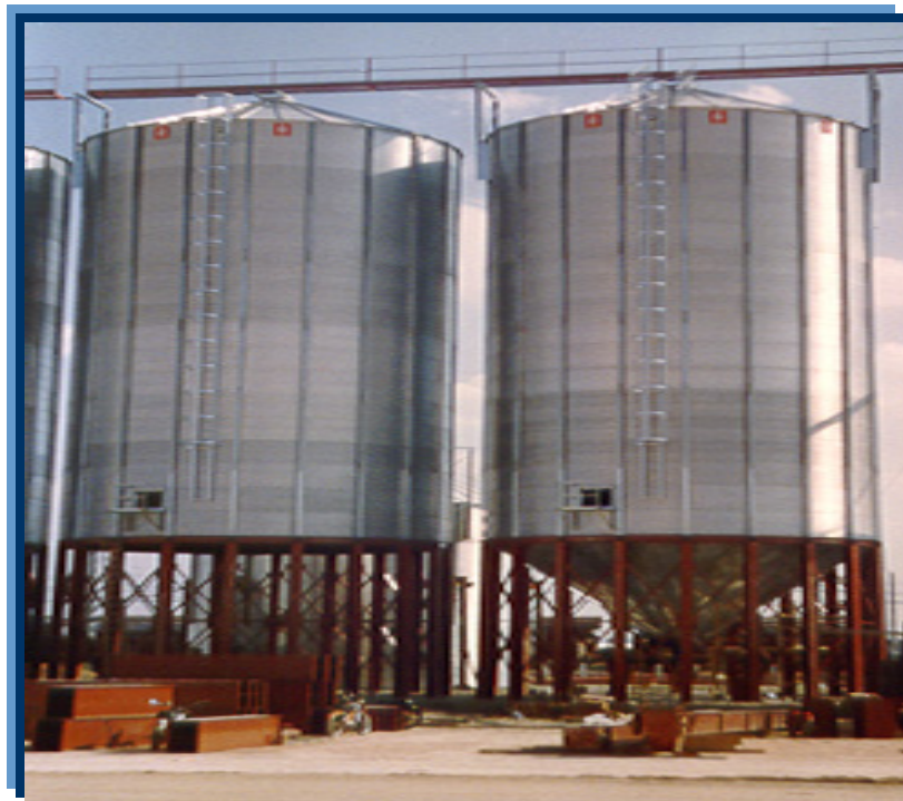
Figura 16. SILOS METÁLICOS Y EN CEMENTO
